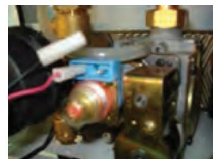
نحوه تست شیربرقی گاز: شیلنگ گاز پکیج را از قسمتی که به لوله گاز خانه متصل شده باز می‌کنیم و در زمان جرقه زنی پکیج اگر با فوت کردن درون شیلنگ گاز مسیر فوت باز باشد شیربرقی گاز سالم و گرنه معیوب است. البته بایستی با اهم‌ترین برق ورودی به شیربرقی گاز را در زمان جرقه‌زنی بررسی گردد در صورت معیوب بودن شیربرقی گاز پکیج تا مرحله جرقه زنی پیش می‌رود اما شعله تشکیل نمی‌گردد.
