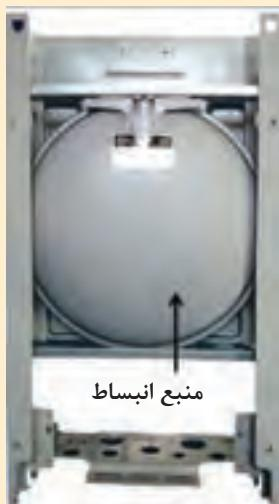
**نحوه تست مخزن انبساط:** فشار هوای داخل منبع انبساط در زمانی که آب در مدار گرمایی نباشد، بایستی بین ۰/۶ تا ۲/۰ بار باشد بنابراین برای تست سالم بودن مخزن انبساط بایستی آب مدار گرمایی را تخلیه کرد و با فشارسنج میزان هوای منبع انبساط را اندازه‌گیری نمود.
