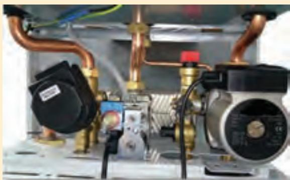
در پوش سیم برق پمپ را بردارید و اتصال برق پمپ به برد را جدا نمایید. اتصال لوله پمپ به مبدل اصلی را بازنمایید. اتصال پمپ به مبدل ثانویه را جدا نمایید. اتصال منبع انبساط به پمپ را جدا نمایید. پیچ هایی که باعث اتصال پمپ به برآکت پایینی می باشد را باز نمایید. پمپ را از جای خود بیرون بکشید (در بعضی از پکیج ها با باز کردن دو مهره ماسوره پمپ از سیستم جدا می شود).
